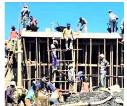
App. 5 Dach -1. Stock - wird betoniert
