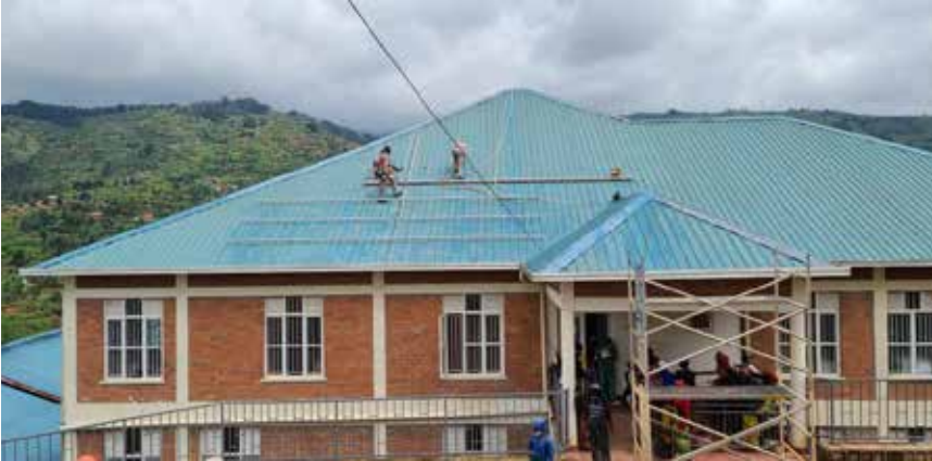
Dachmontage der Profile
