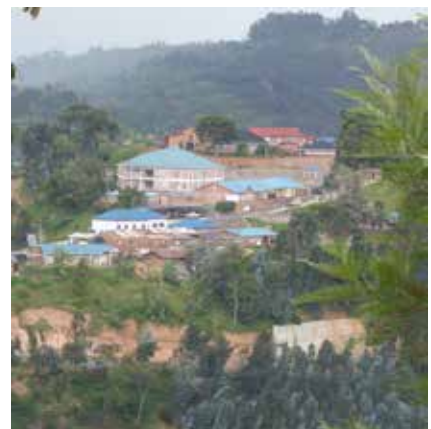
Murunda-Hospital und Gästehaus
