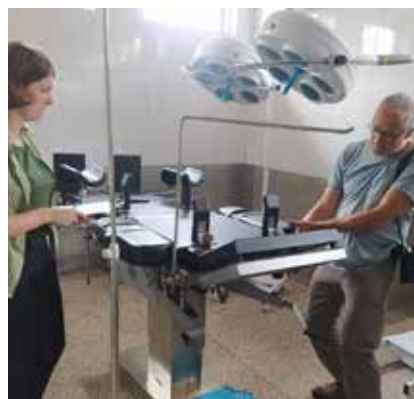
Julia und Rolf der Sektion Eschweiler - Installation OP-Tisch
