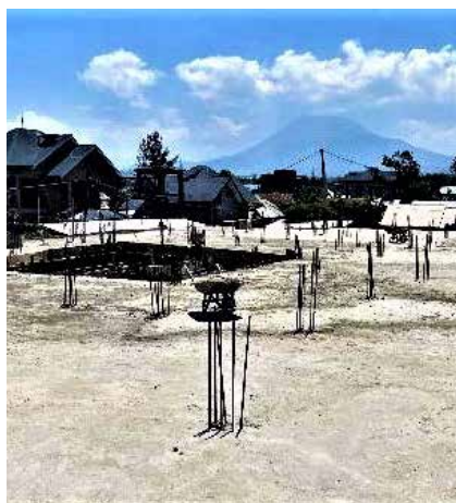
App. 6 Dach mit Vulkan im September 2021
