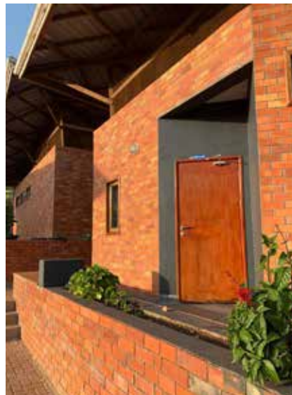
Neue Behandlungsräume warten ...
